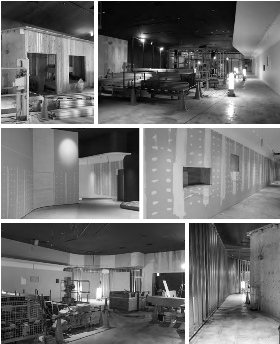
常設展示工事中の様子
